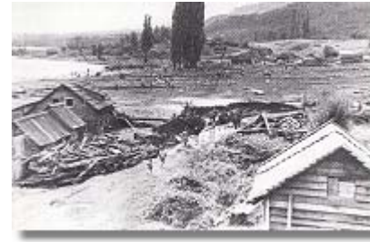
Lado opuesto del cauce lahárico. Estas casas quedaron intactas por ubicarse al margen del lahar. Una gran cantidad de maderas depositadas por el flujo obstruyen el camino de acceso a Coñaripe.
